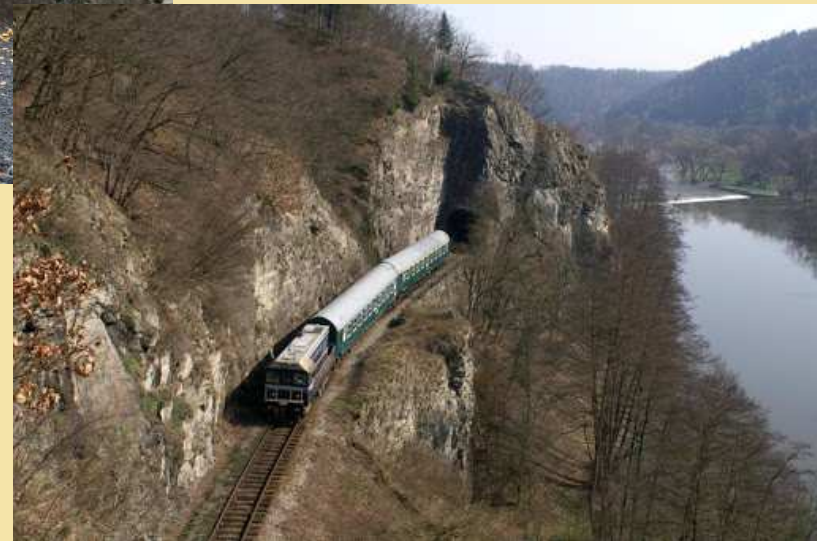
Železniční tratě ve skalních zářezech
