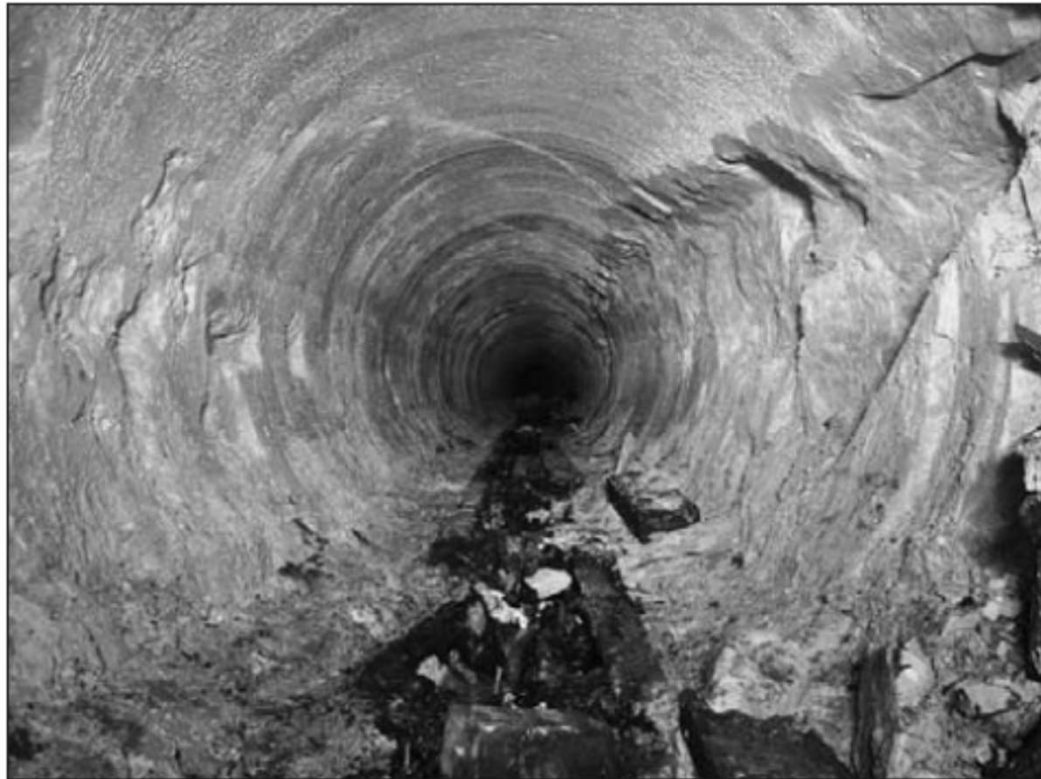
Průzkumná štola vyražená v roce 1881 strojem Beaumont/English (1. pokus o Channel Tunnel)
