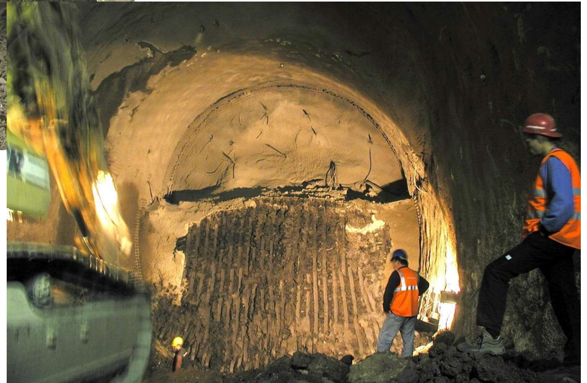
Zastříkaná čelba s laminátovými svorníky
