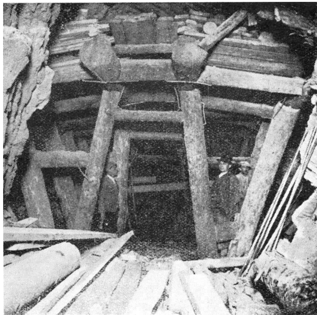
Korunní podélníky v kalotě
