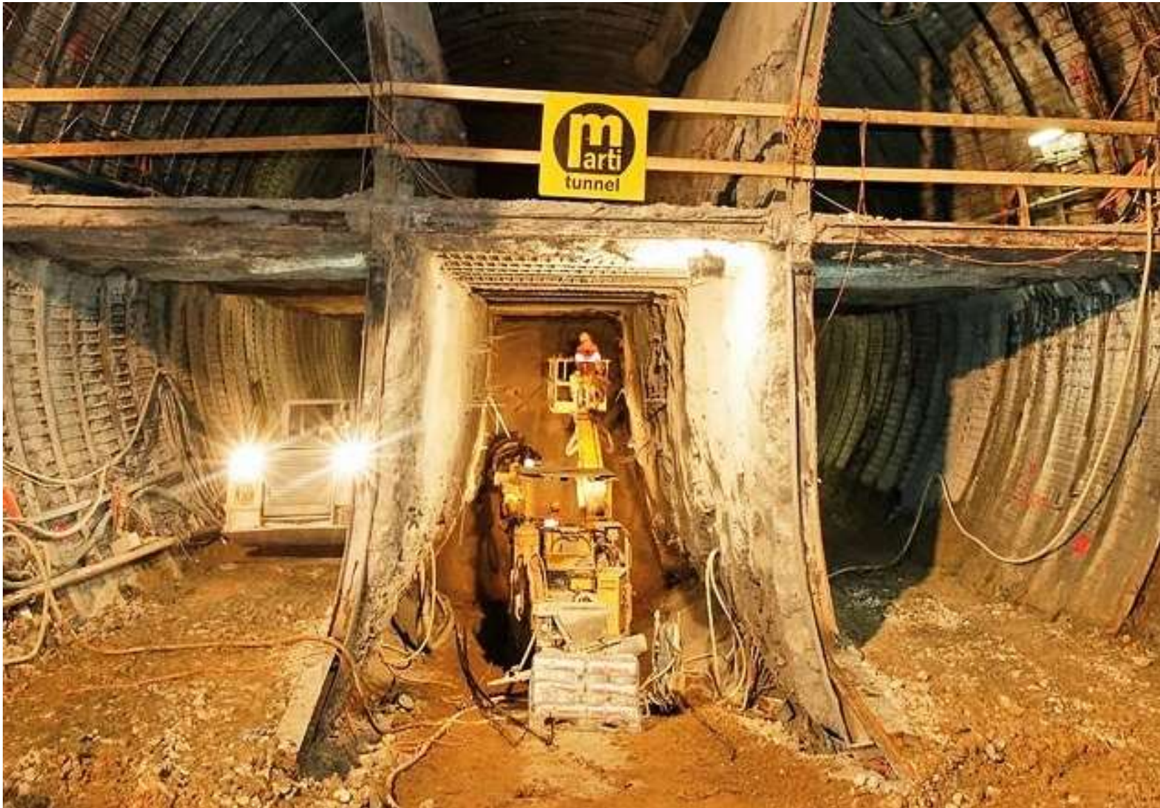
Varianta dodatečného pobírání jádra s ponechávaným rozepřením
