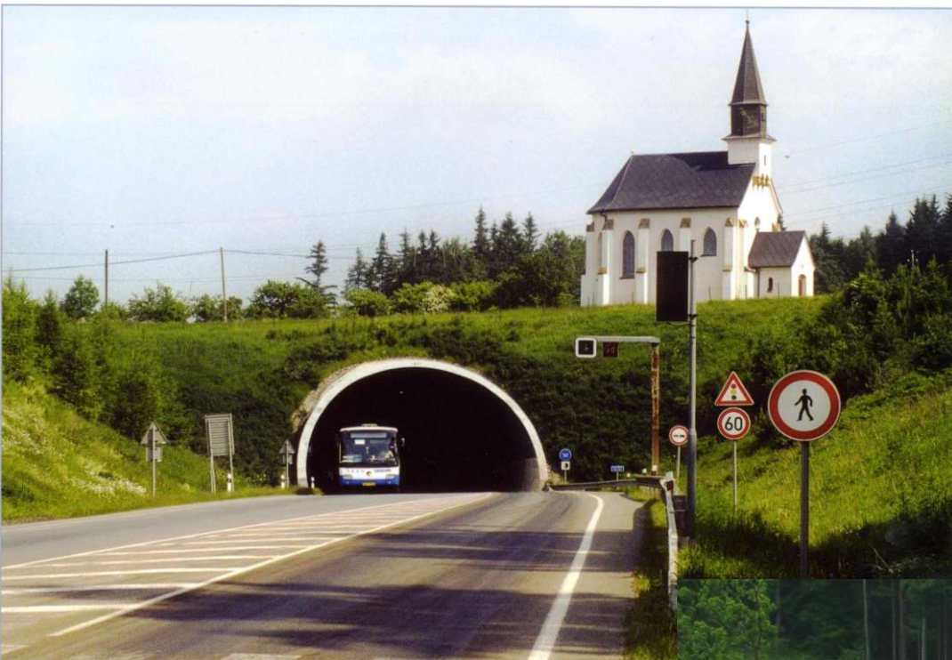
Tunel Hřebeč silnice I/35, délka 355 m
