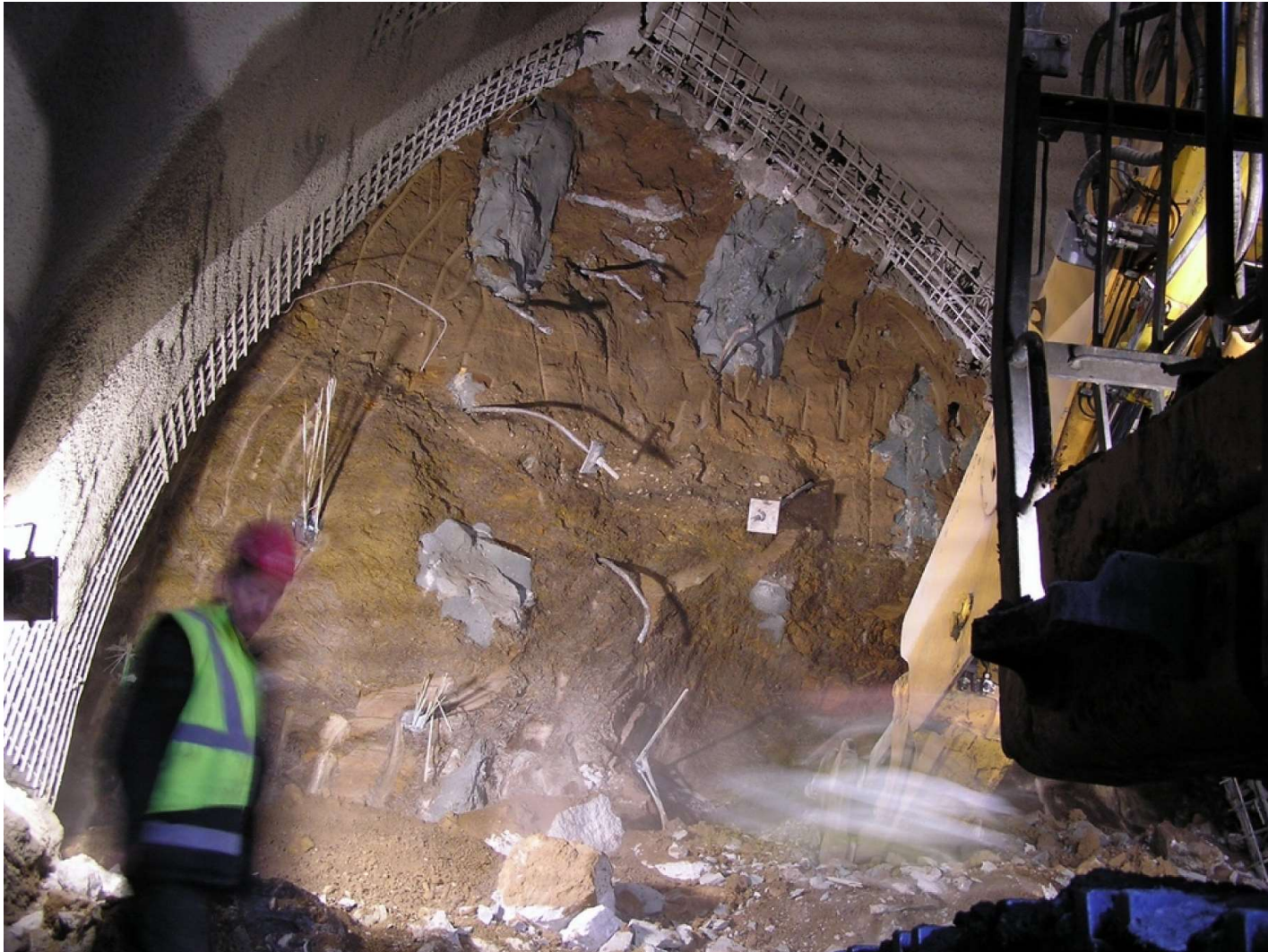
Třípruh Brusnického tunelu (Prašný most)
