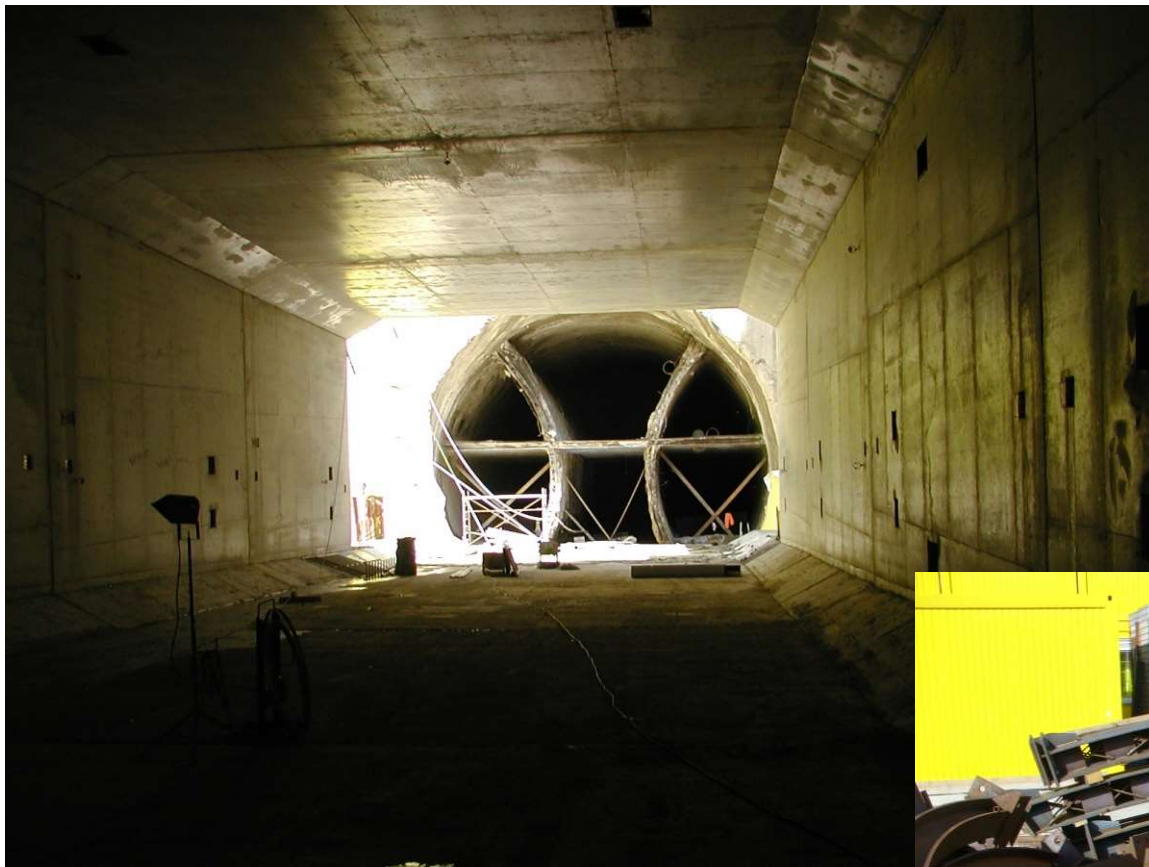
Plný výlom raženého tunelu
