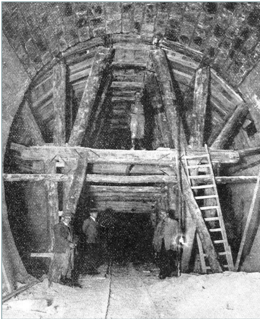
Rakouská soustava (zajištění výrubu výdřevou)
