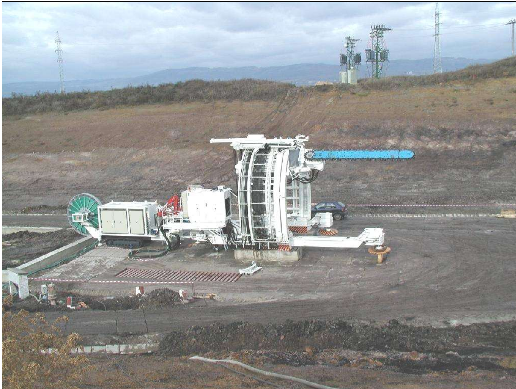
Vrubovací stroj PERFOREX na tunelu Březno
