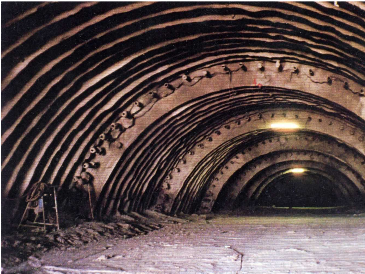
Dálniční tunel Epomeo Itálie
