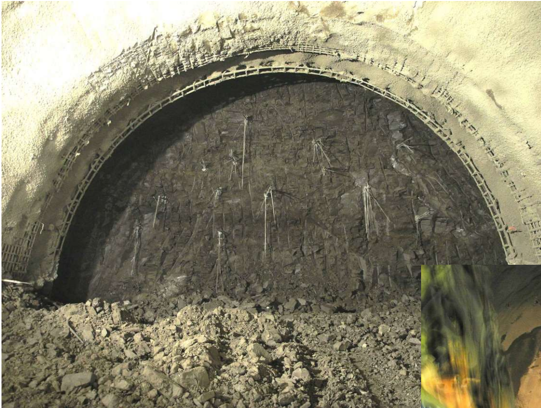
Nezastříkaná čelba s laminátovými svorníky
