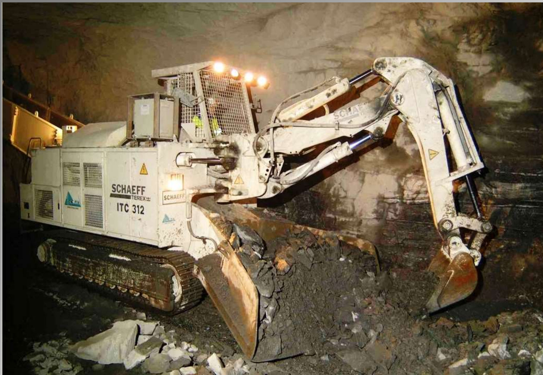
Tunelový bagr SCHAEFF – Královopolský tunel, Brno
