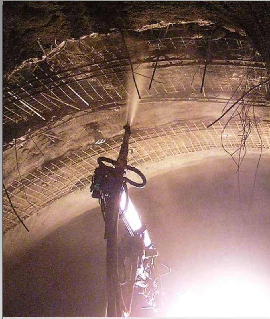
Primární ostění v kalotě výrubu
