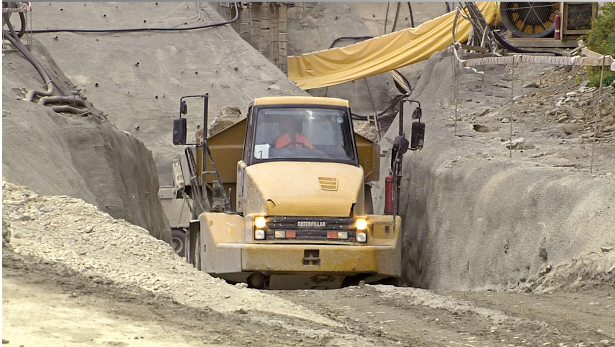
Primární ostění v kalotě výrubu
