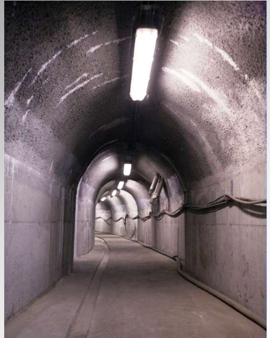
klenba ze stříkaného betonu
