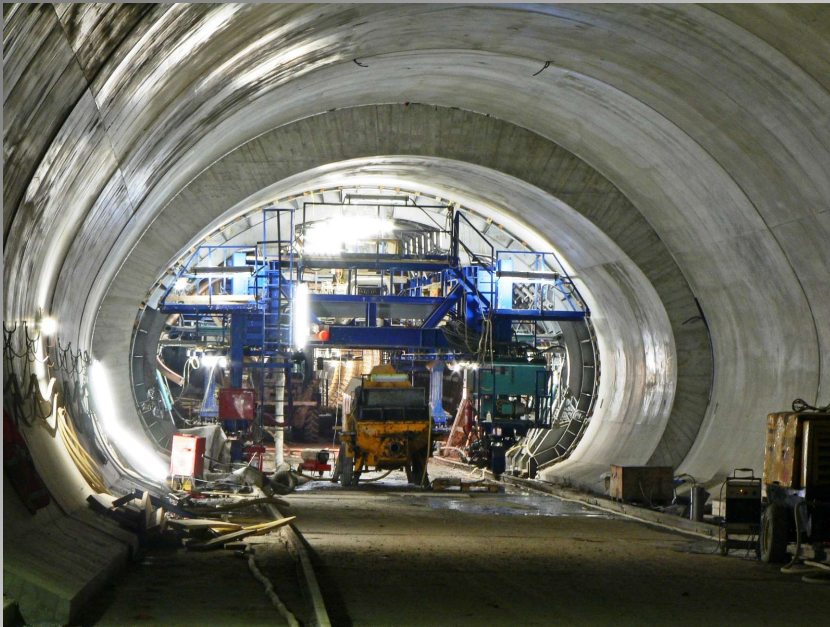
Betonáž definitivního ostění na obrátovém tunelu v Motole (prodí „A“)
