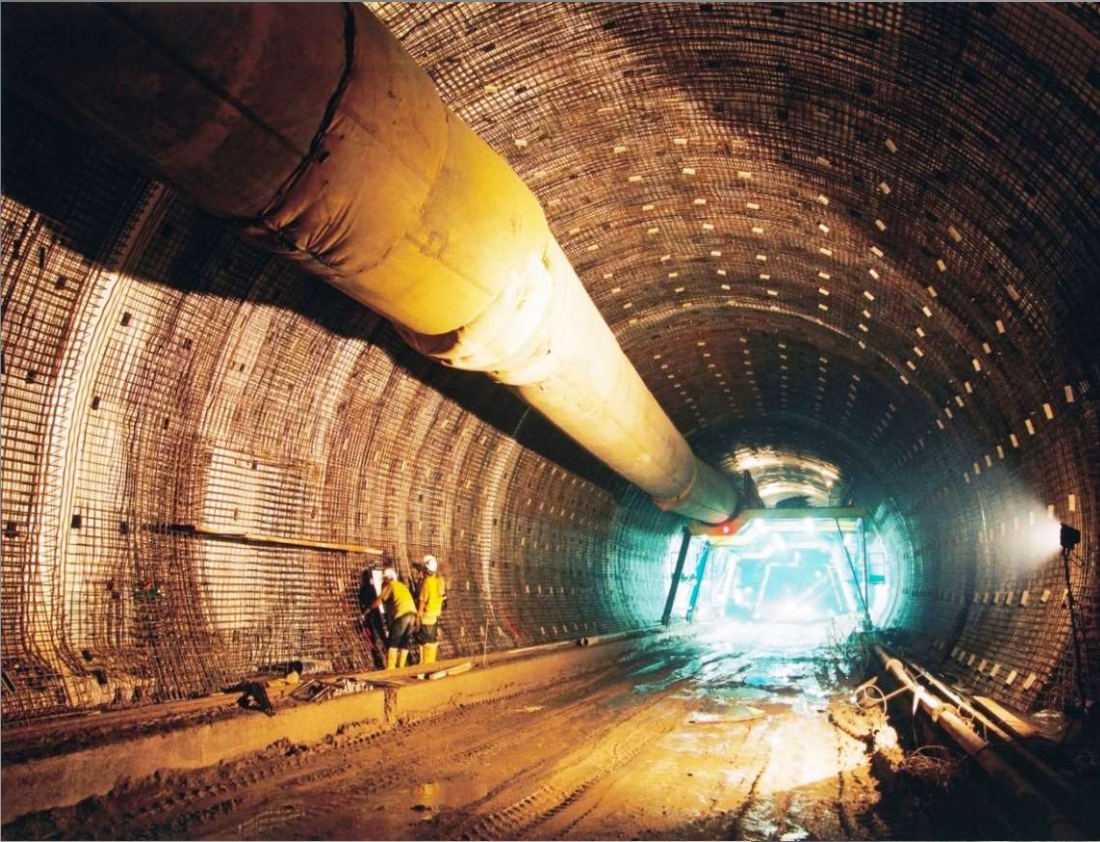
Tunel Panenská Dálnice D8 dl. 2168 m (2006)
