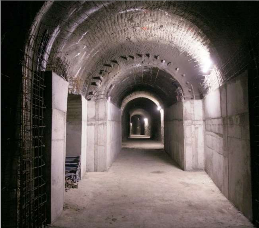
Opěry z monolitického betonu
