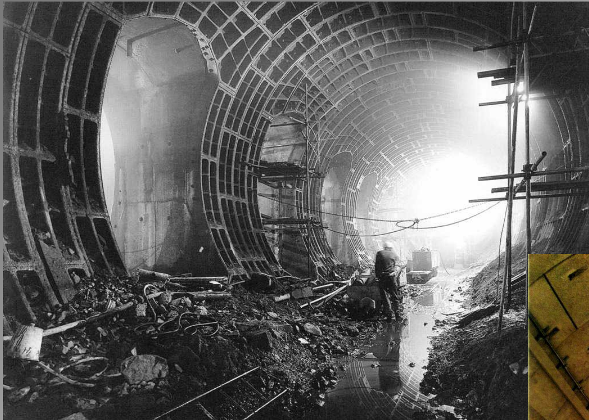
Trojlovní stanice metra Hradčanská (ocelolitina)
