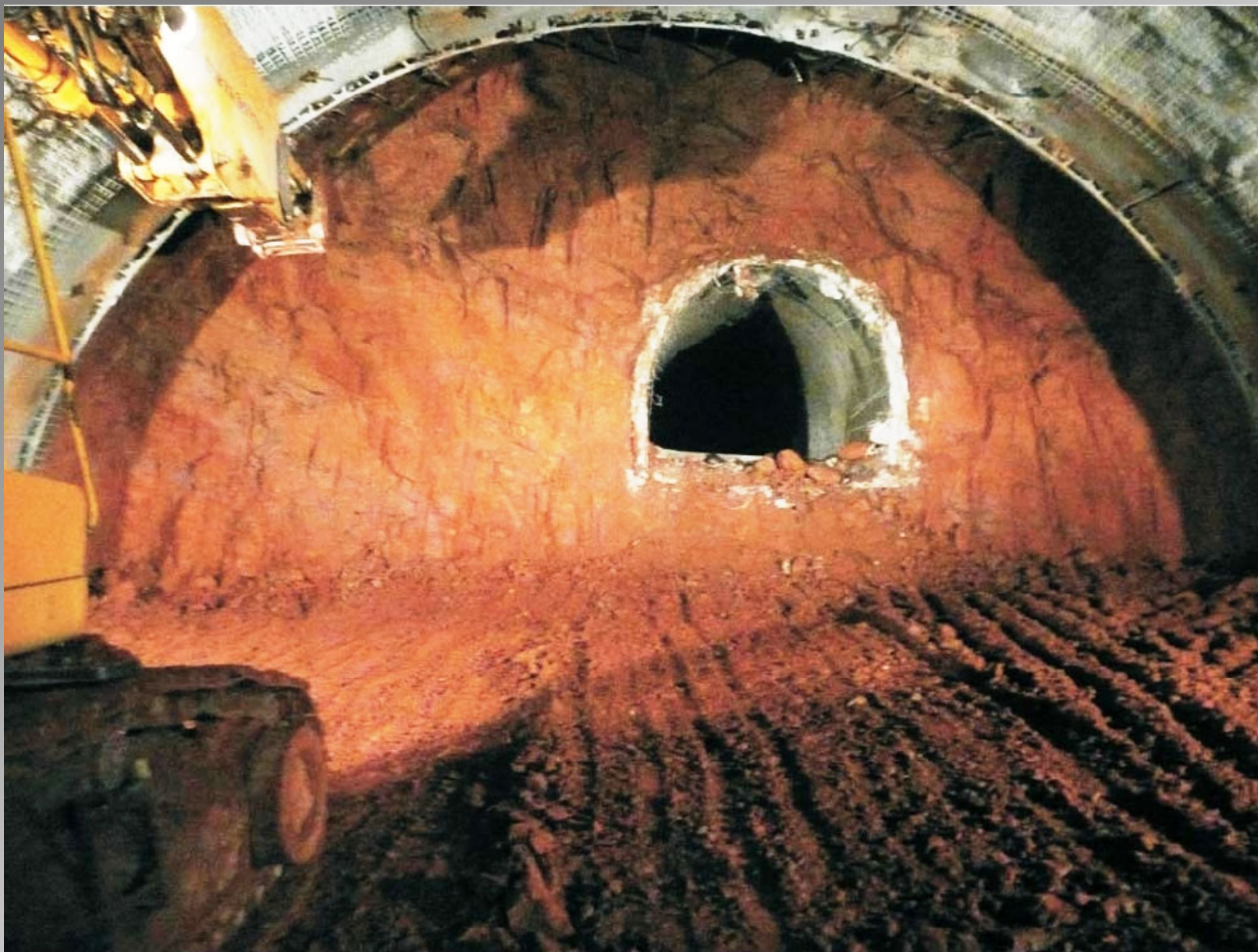
Průzkumná štola tunelu Prackovice (dálnice D8)
