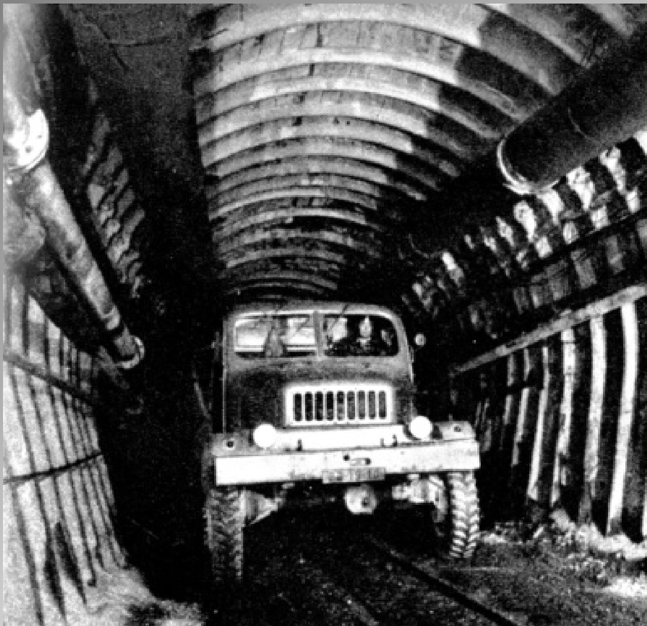
Vodovodní přivaděč Želivka (1964 až 1972)
