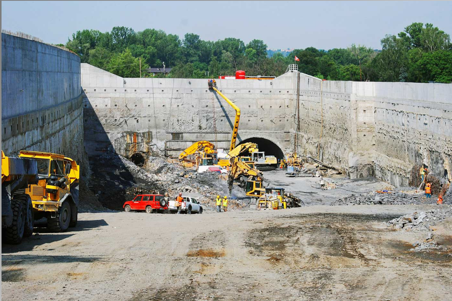
Kombinace pažené jámy a protipovodňové ochrany – Bubenečský tunel v Troji
