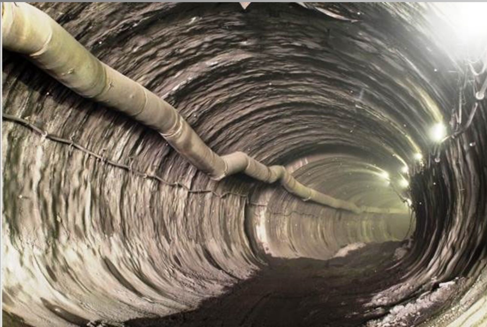
Primární ostění Brusnického tunelu
