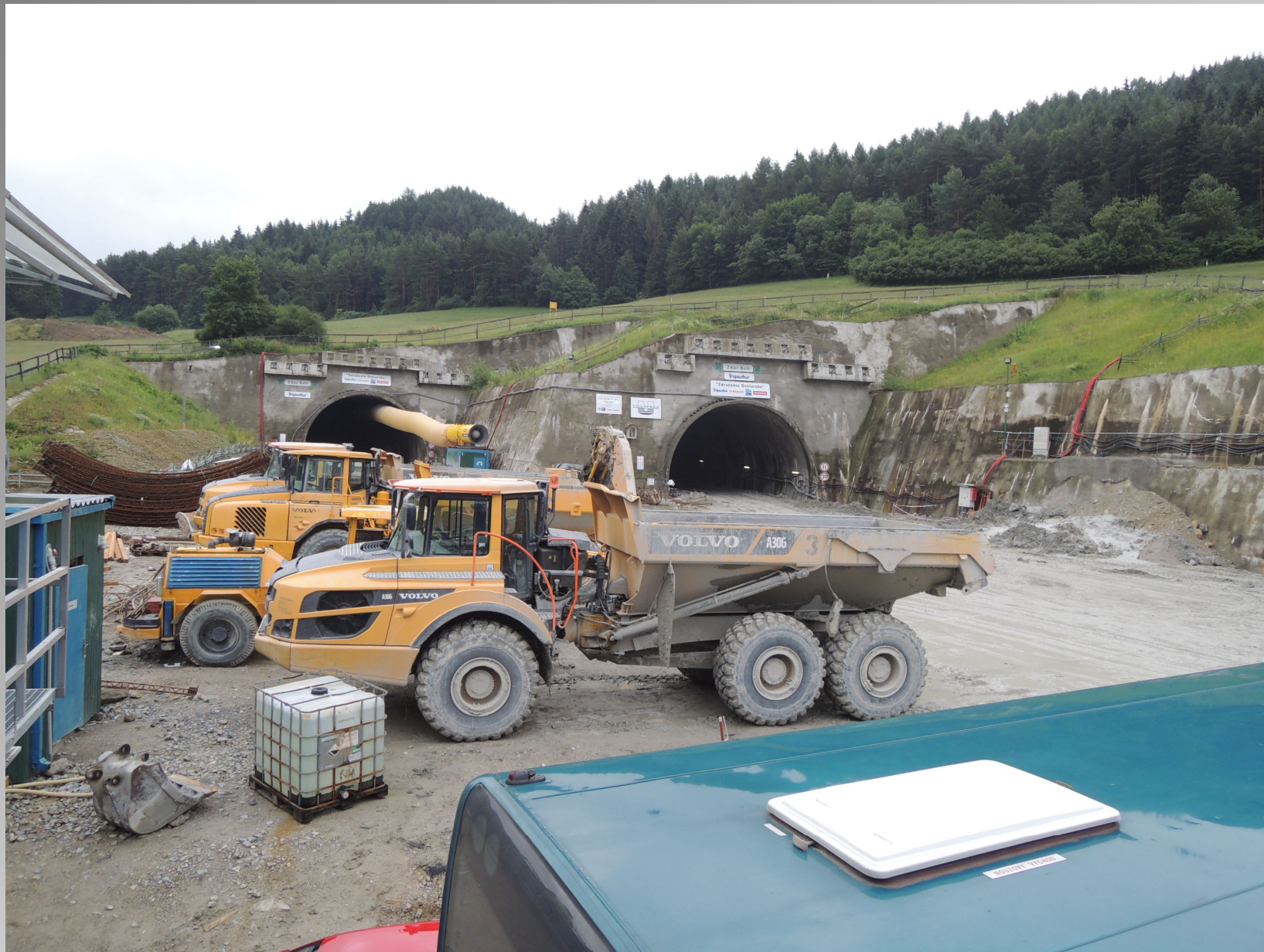
Tunel Ovčiarsko, SK
