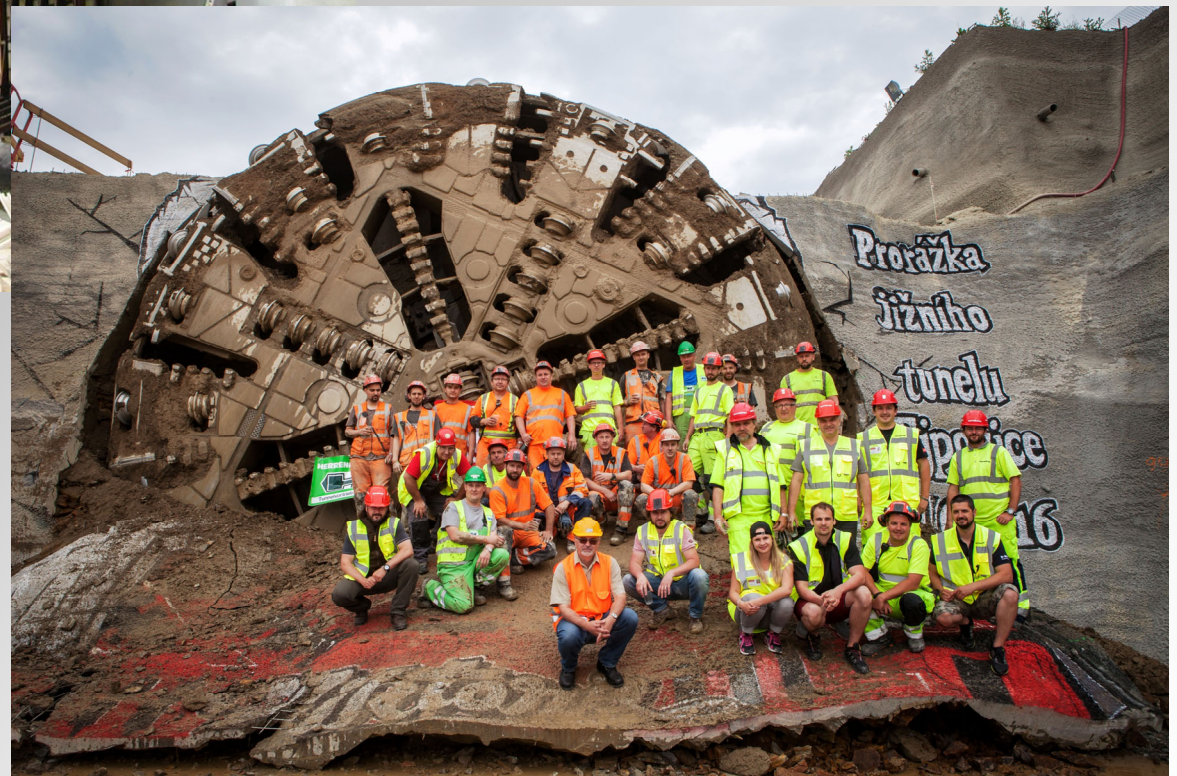
Ražený tunel (Ejpovický tunel)
