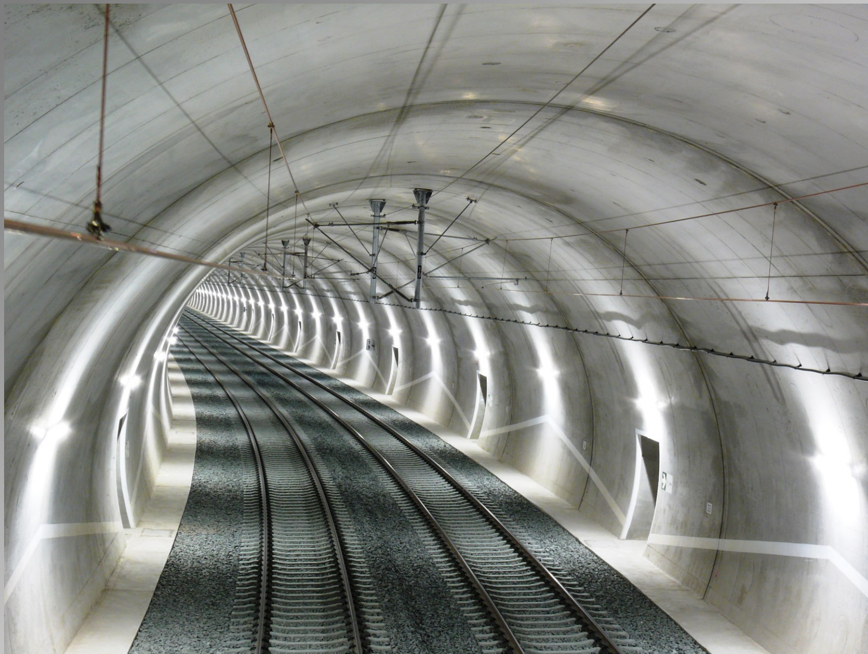
Krasíkovský tunel – III. žel. koridor
