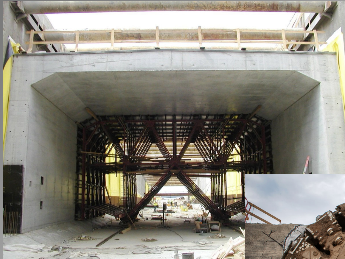
Hloubený tunel v pažené jámě
