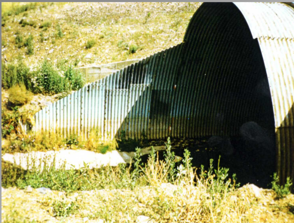
Dálnice D5 Bavoryně – Červený potok
