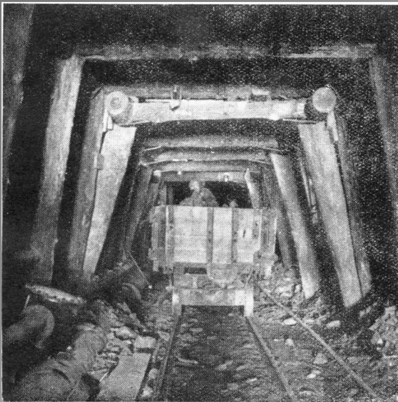
výdřeva směrové štoły
