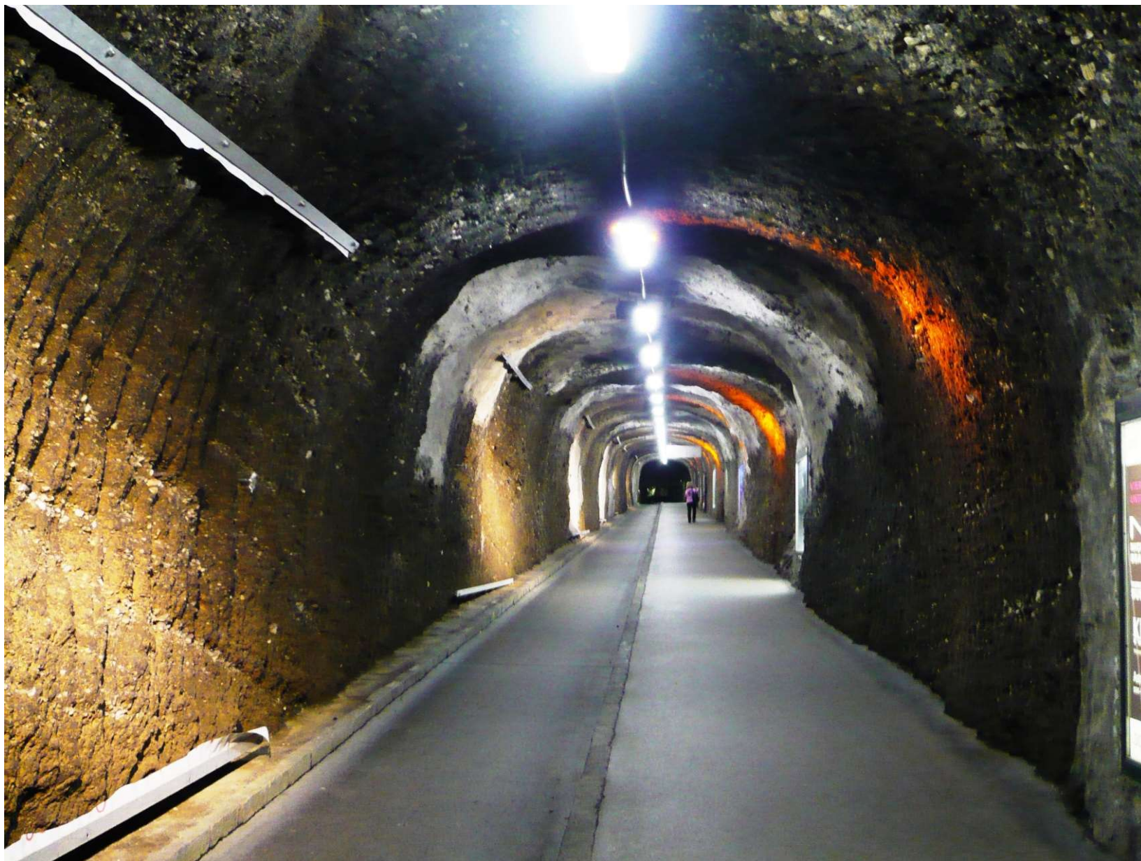
Novodobý tunel pro pěší a cyklisty vybudovaný paralelně s tunelem Neutor
